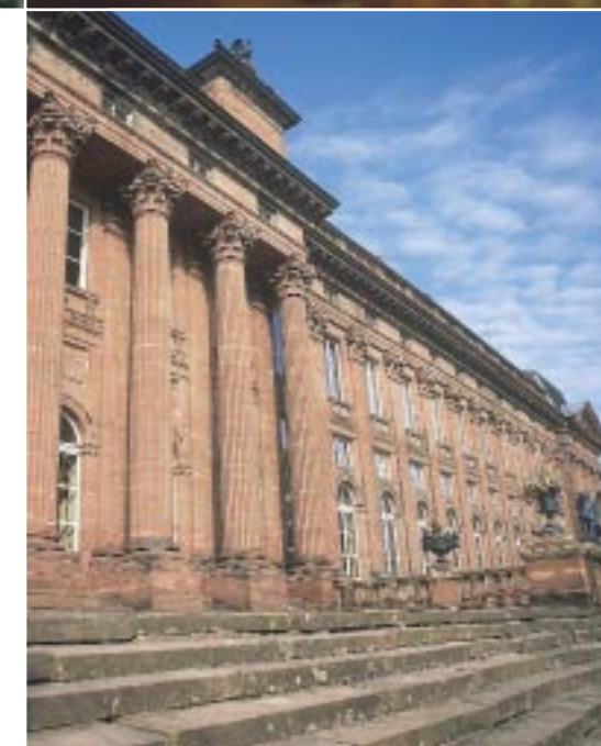
Château des Rohan à Saverne : résidence épiscopale du 18 ème siècle
